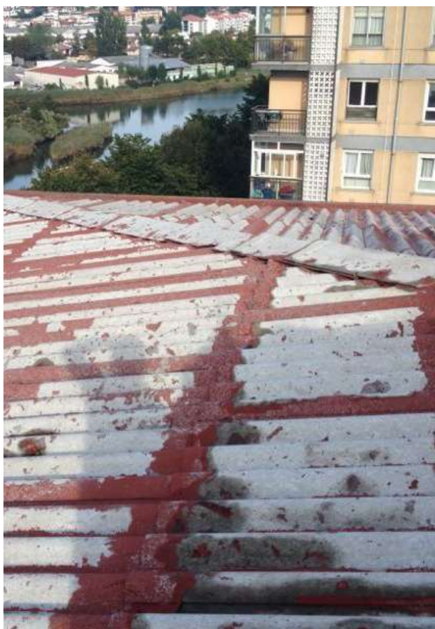
Cubierta antes de ser tratada con VIPEQ F10
