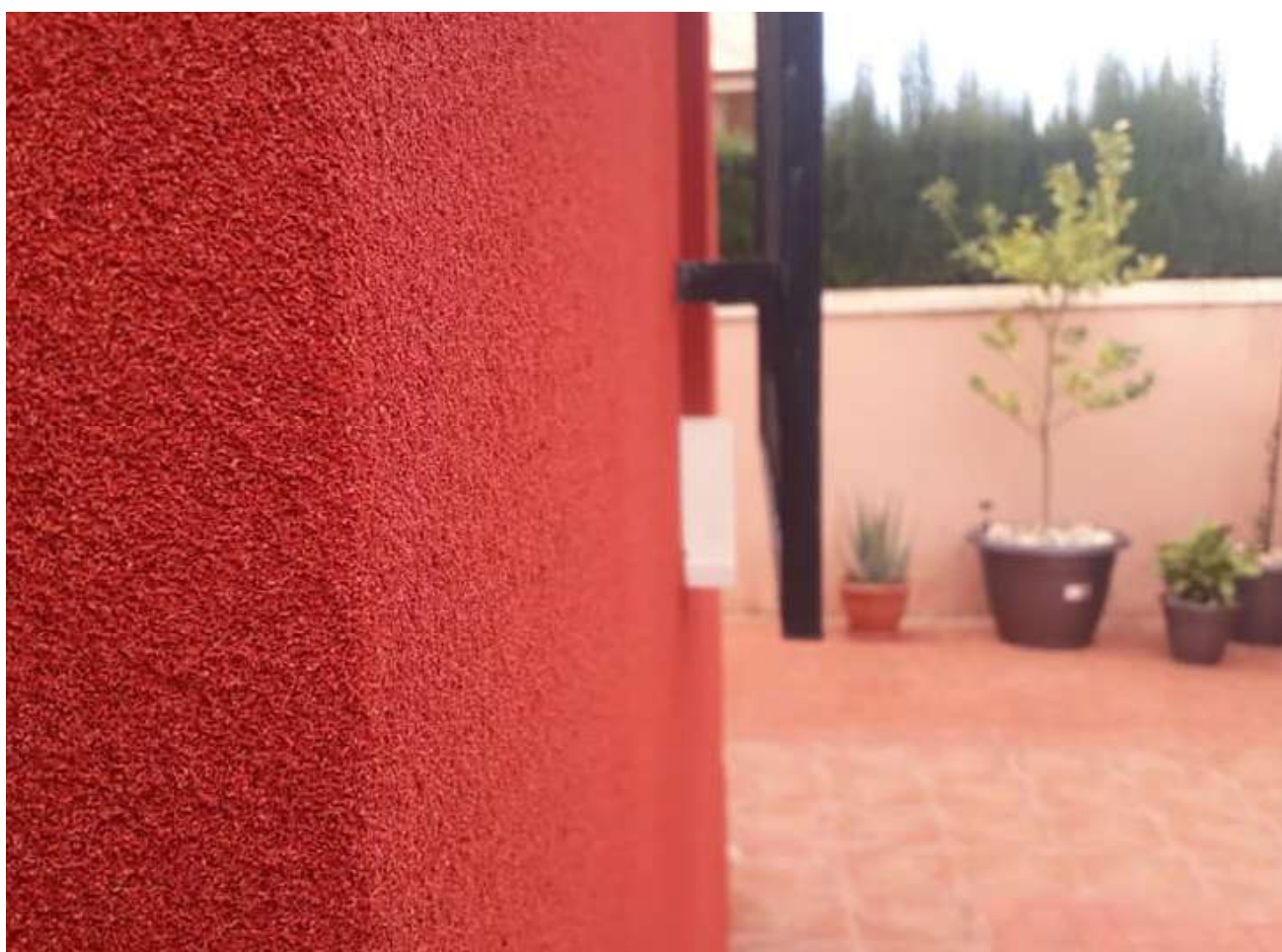
Toma del muro que muestra la textura.
